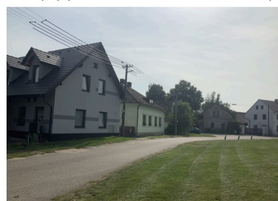
novostavba v místě původní zástavby
