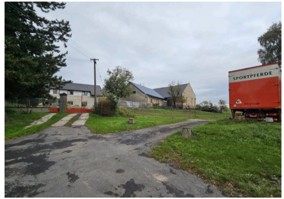
nesjednocené asfaltové a panelové cesty v západní části
