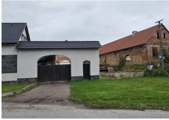
Plocha návsi je rozčleněna příjezdovými cestami, které se od sebe navíc liší materialitou, což faktor rozčlenění posiluje.
